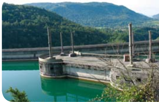
Chaque turbine est alimenté par une conduite forcée venant des puits de prise d'eau situés à l'amont du barrage.
