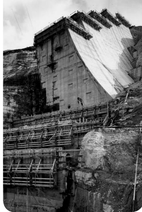
La construction du barrage de Vouglans a nécessité 545 000 m 3 de béton.
