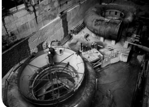
Construction de l'un des groupes de production d'électricité de la centrale de Vouglans.
