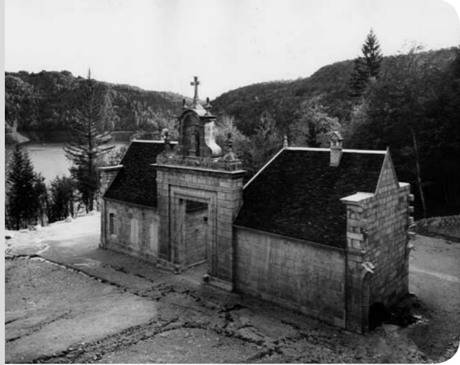
EDF a démonté pièce par pièce le portail de la Chartreuse de Vauluse, joyau du X e siècle, pour le reconstruire à l'abri des flots, près du village d'Onoz.
