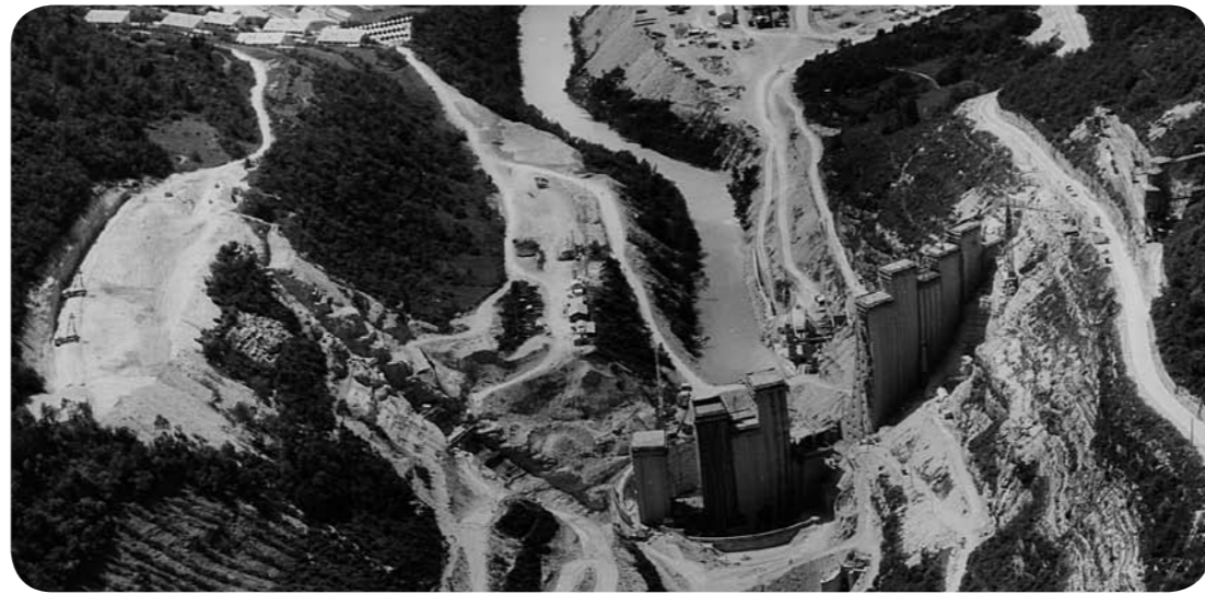
La construction du barrage de Vouglans a nécessité 545 000 m 3 de béton.
