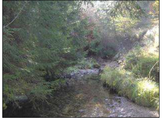
Anse d'érosion en rive droite
