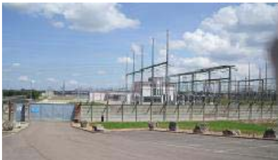
Poste de transformation
