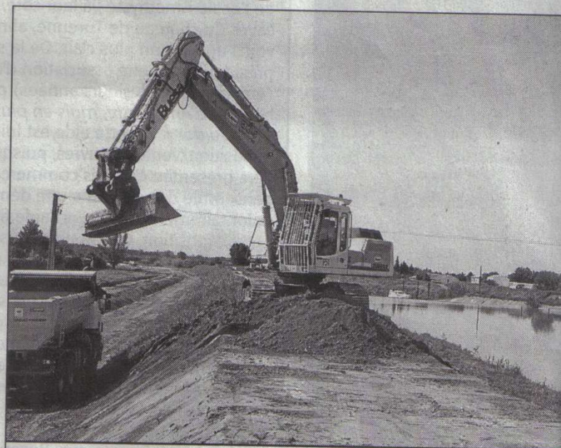
Vingt-deux mois d'un lourd chantier pour tout réhabiliter.
