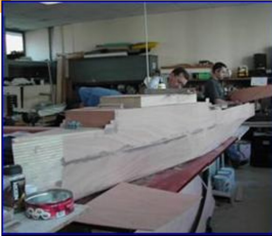
LSD en construction
