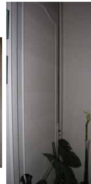
Porte sur balcon
